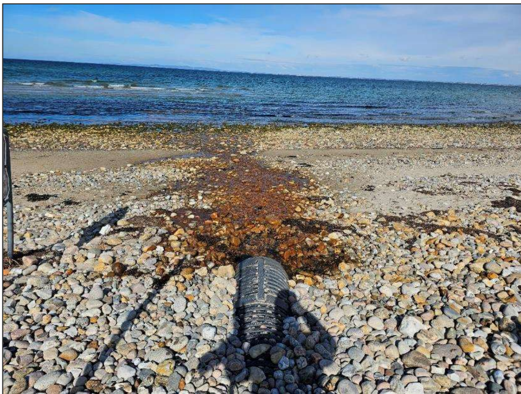
Figur 6-50: Helsingør 3. View fra rørudløb ned over strand mod vandkant. Foto er taget ved besigtigelse den 4. april 2023.
