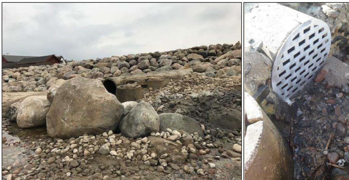
Figur 6-3: Udløb af Kikhavn Vandløb. Foto er fra 2020 og udleveret af Halsnæs Kommune. Billedet til venstre er fra før risten blev installeret.
