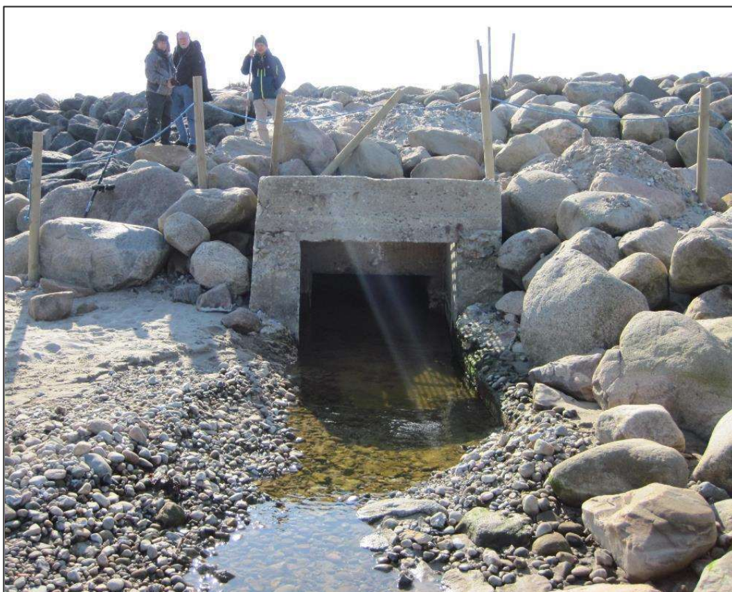
Figur 6-8: Udløb af Nødebohuse Pumpekanal. Foto er taget ved besigtigelse den 11. april 2021.
