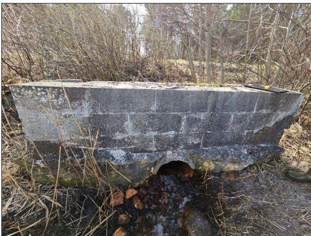
Figur 6-41: Helsingør 1. Ø400 rørudløb i beton med udløbsbygværk. Foto er taget ved besigtigelse den 4. april 2023.
