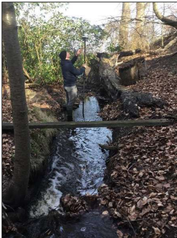
Figur 6-67: Helsingør 6. Nedstrøms rørudløb. Foto er taget ved besigtigelse den 4. april 2023.
