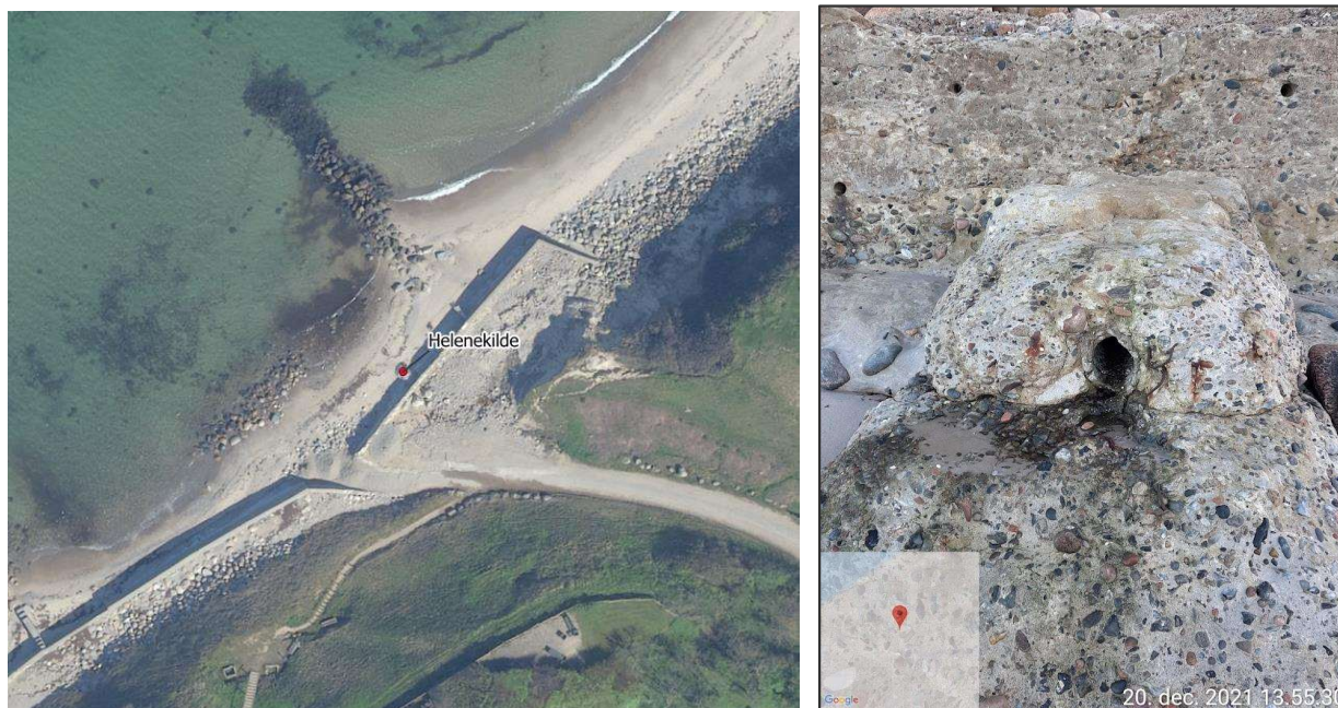
Figur 6-14: Venstre: Placering af udløb ved Helenekilde.. Højre: Foto af udløb ved Helenekilde. Foto udleveret af Gribskov Kommune.
