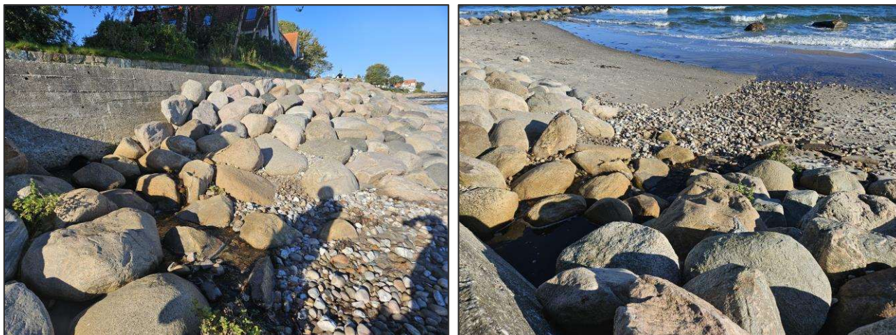
Figur 6-56: Majorgårdens udløb på stranden gennem betonvæg.
