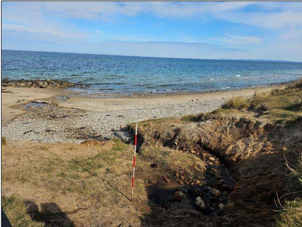
Figur 6-27: Gribskov 1. Vand havde eroderet en kanal gennem klitten og løb herefter diffust ned over stranden. Foto er taget ved besigtigelsen den 4. april 2023.
