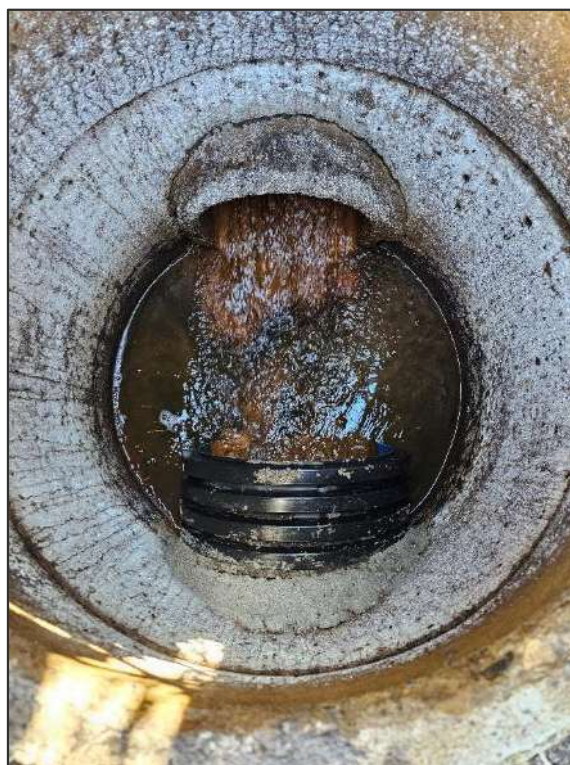
Figur 6-51: Helsingør 3. Foto ned i nærmeste opstrøms liggende brønd. Foto er taget ved besigtigelse den 4. april 2023.
