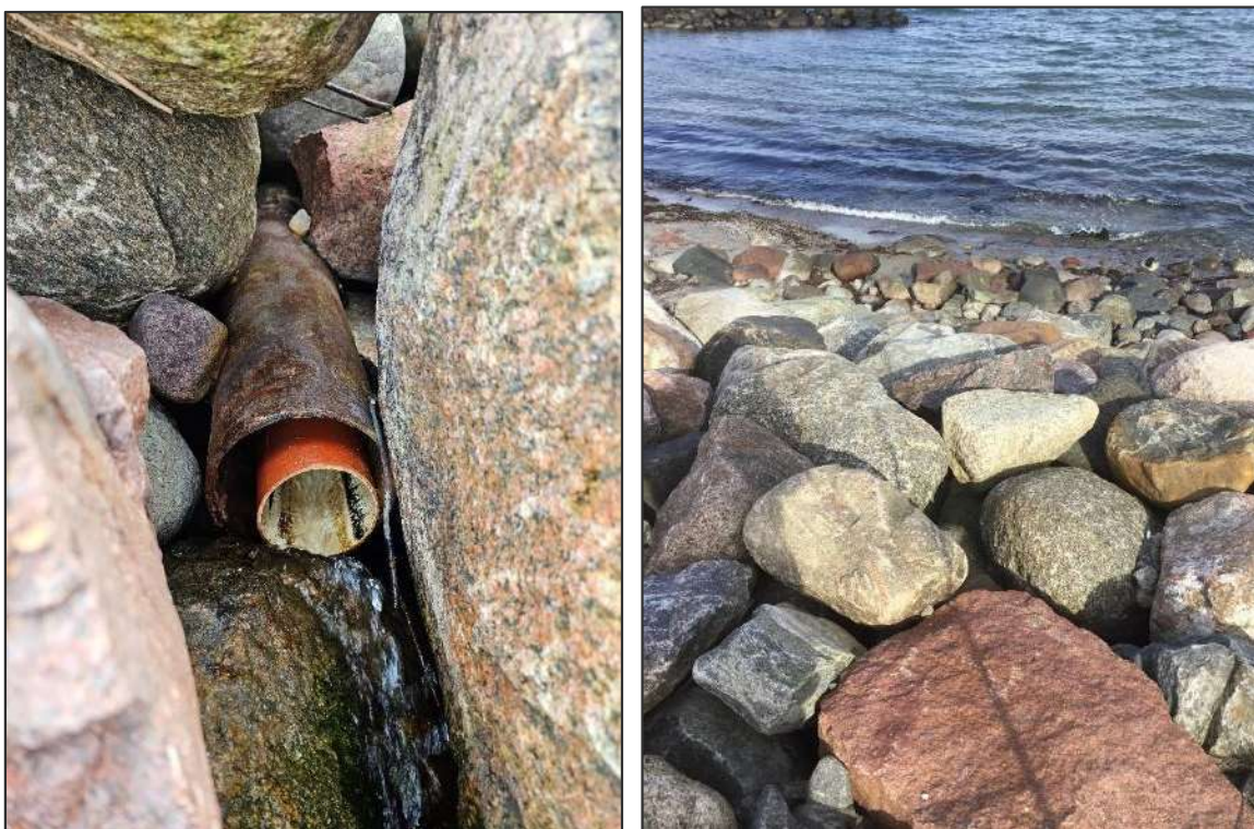
Figur 6-1: Halsnæs 1. Venstre: Rørudløb i kraftig stenskråningskystbeskyttelse. Foto taget ved besigtigelse den 4. april 2023. Højre: View fra rørudløb mod vandkant. Foto er taget ved besigtigelse den 4. april 2023.
